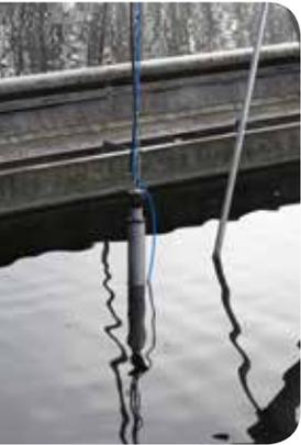
Abb. 1: Installation des Sensors NiCaVis® 705 IQ im Nachklärbecken der Kläranlage Peißenberg
