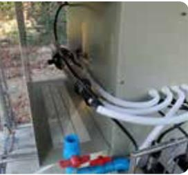
Spektralsensor installiert mit Durchflussarmatur sowie zusätzlicher Druckluftreinigung für besonders lange Standzeiten des Sensors.
