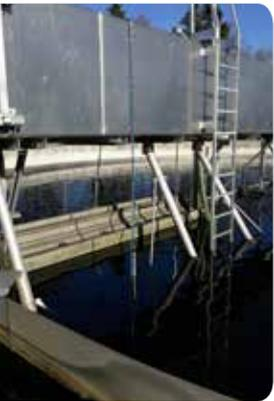
Abb. 2: Installation des Sensors NiCaVis® 705 IQ im Nachklärbecken der Kläranlage Peißenberg
